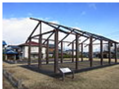
掘立柱建物跡
