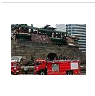
鎮火後の様子
