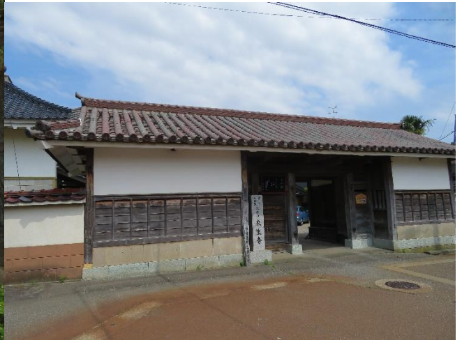
移築 鰻橋御門(来生寺内)
