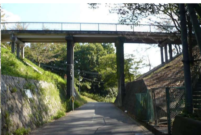
大堀切跡を下部より
