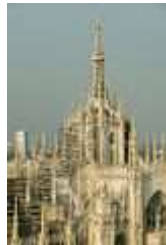
屋根の上は登れる [4] 修復中の尖塔群
