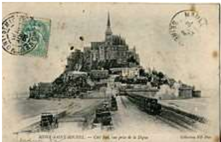
堤防造成による鉄道・道路(1905年)
