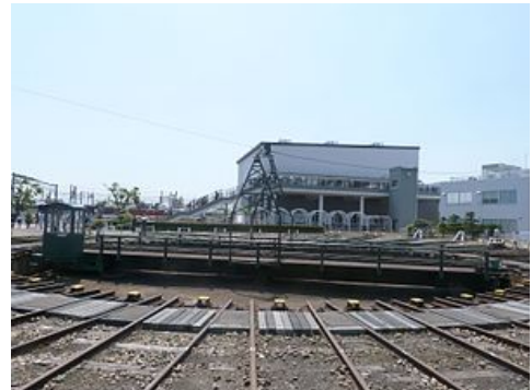
機関庫側から見た転車台。向かいの本館屋上にはスカイテラスがある
