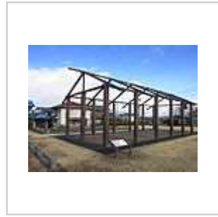
掘立柱建物跡
