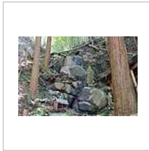
落石で荒れた浄瑠璃 寺奥之院(2020年2 月の様子。手前 には、丸彫の不動明王 石仏が立っていた。)
