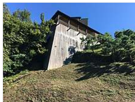
板張りの外壁部分
