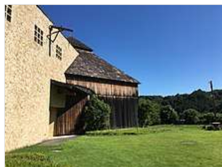
木製の雨樋がある外壁
