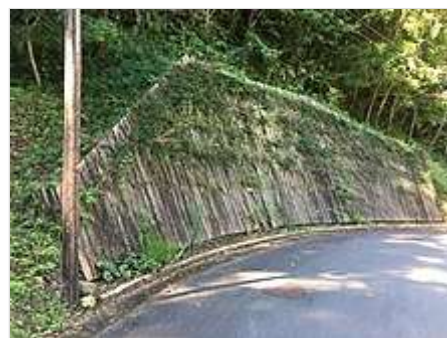
コンクリートに板を張った擁壁
