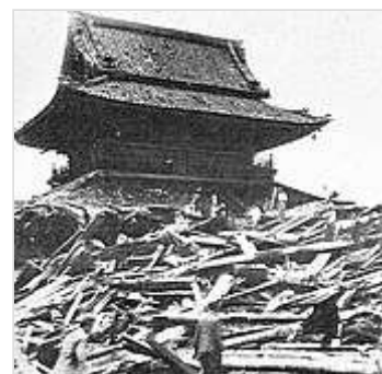
室戸台風で倒壊した6代目五重塔
